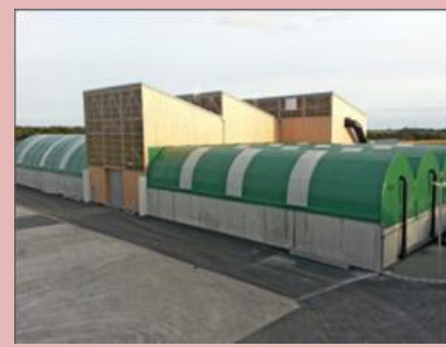
Compostage en tunnel
